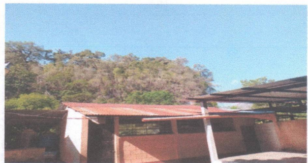
Foto 6: Se observa la necesidad de sustituir la cubierta de lámina (Módulos 1,2 y 3)
