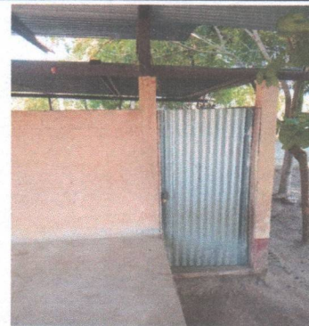
Foto 4: Se observa la necesidad de sustituir una puerta de lámina por una de metal.
